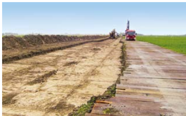
Baggermatten zum Bodenschutz
