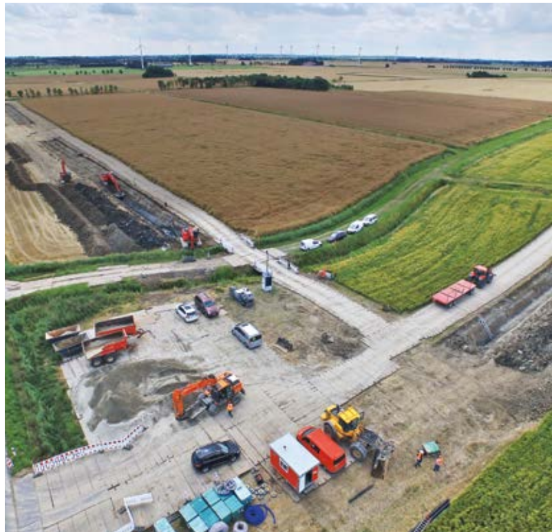
Überblick: Bodenschutz beim Bau
