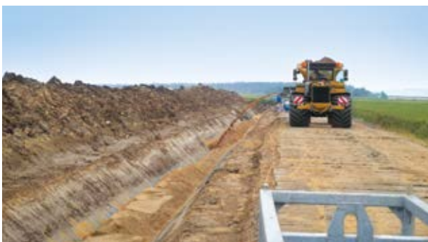
Einsanden der Erdkabel
