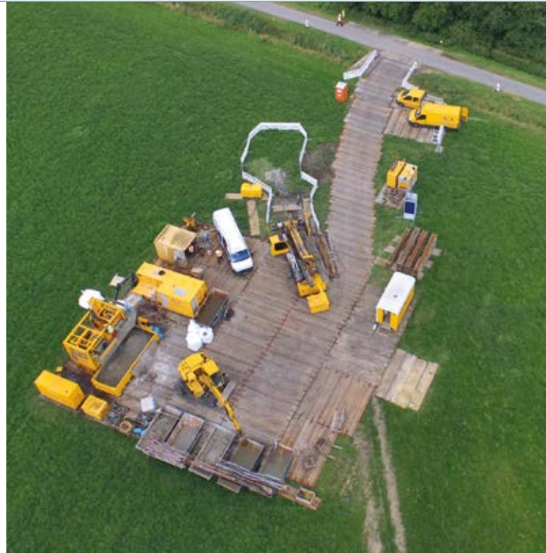
Geschlossene Verlegung durch HDD
