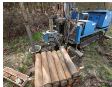
Links: Rammsondierung Mitte: Rammsondierspitze Rechts: Kleinfahrwerk mit Kettenfahrwerk einer Rotationskern- bohrung
