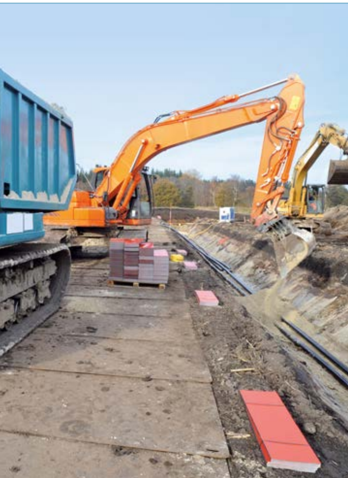
Rückverfüllung des Kabelgrabens
