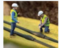
Die Kabelverbindung: Prüfung Muffen
