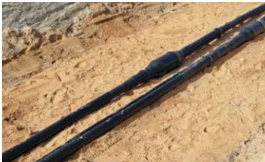
Fertige Muffen vor dem Verfüllen mit Bettungsmaterial
