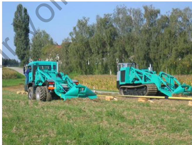
Abbildung 11: Unterschiedliche Zugmaschinen im Einsatz (Quelle: Firma IFK Österreich, http://www.verlegepflug.at/pfluegen-bilder.html )
