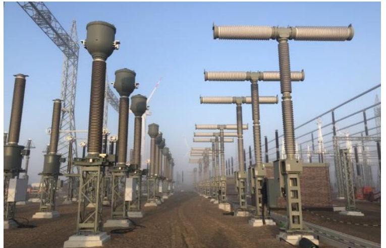
Die Arbeiten im Umspannwerk Handewitt gehen sichtbar voran.
