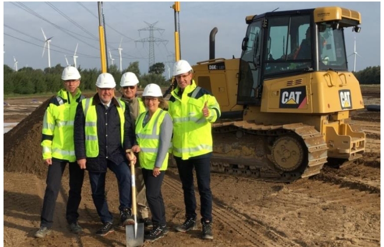
Spatenstich für das Umspannwerk Schuby: Bürgermeisterin Petra Schulze und der stellvertretende Landrat Walter Behrens (vorn), hinten von links: Projektleiter Bau Danny Stieper, Schubys ehemaliger Bürgermeister Helmut Ketelsen und Mittelachsen-Gesamtprojektleiter Dirk Jonassen
